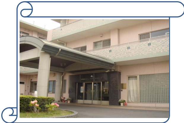
施設外観（3階建て）
