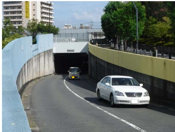
吹田片山地下道
