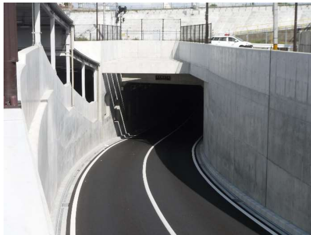
南吹田地下道
