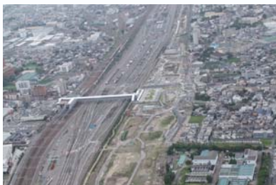
吹田操車場跡地（現在）
