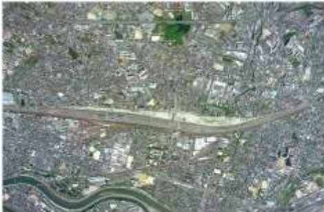
吹田操車場跡地全体航空写真
