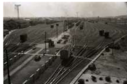
操業開始当時の吹田操車場
