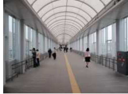
南北自由通路（内部）
