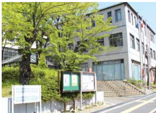
現在の吹田保健所（出口町）
