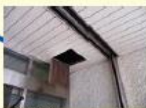
玄関横シャッター周り
