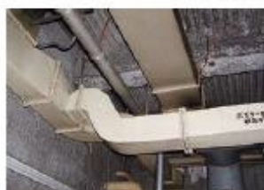
機械室の吹付け材
