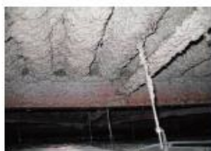
天井裏の吹付け材
