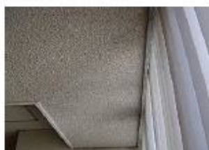
天井パーミキュライト仕上げ
