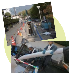
▲改築更新工事
