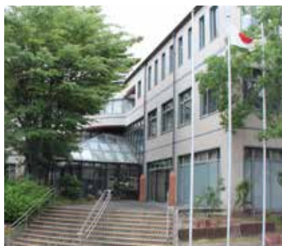
中核市移行で大阪府から保健所の権限が移譲されます（吹田保健所）
