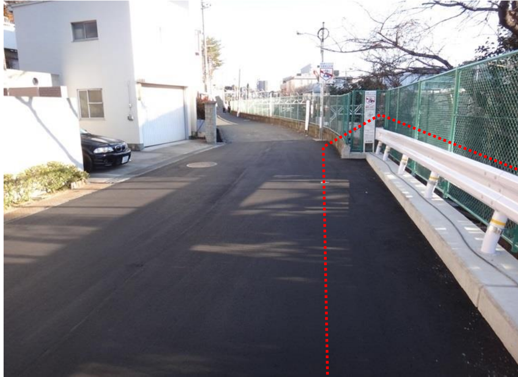
写真内の点線で囲った範囲を拡幅し、擁壁と防護柵を新設しました。
