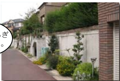
擁壁前に植栽スペースを設け、地域へのつながりとなっています。
