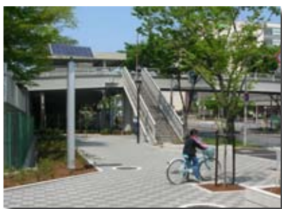
舗装材と調和する色彩の歩道橋。
