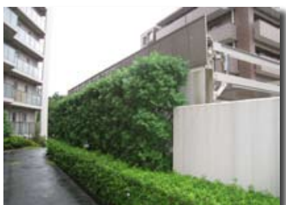
機械式立体駐車場を植栽で見えにくくしています。
