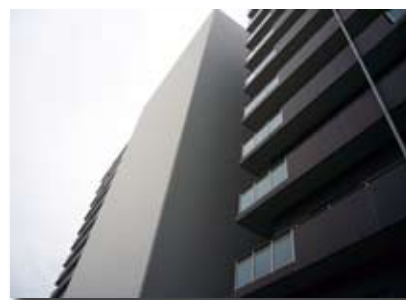
シックな色の立体駐車場で建物に調和しています。
