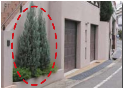
擁壁の位置を少し後退させて植栽を設けています。
