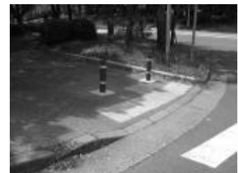
視覚障害者誘導用 ブロックの不備
