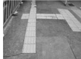
ほそう しかくしょうがいしゃゆうどうよう 舗装・視覚障害者誘導用 ブロックの老朽化
