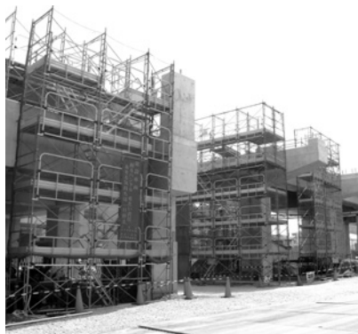
南吹田における新駅建設工事
