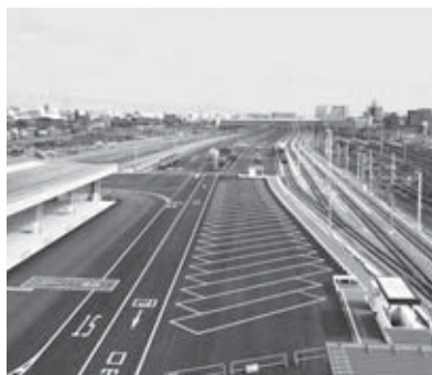
本年3月に開業した吹田貨物ターミナル駅
