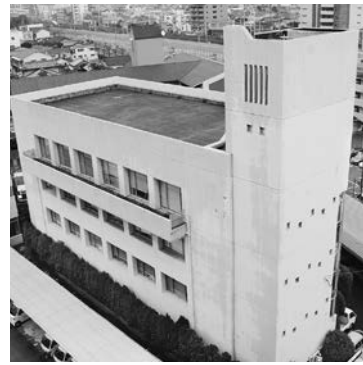
耐震診断が未実施の職員会館
