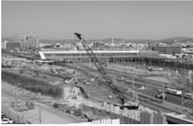
建設工事が進む東部拠点
