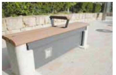
災害時にかまどとして使用できるベンチ(いずみ南公園)
