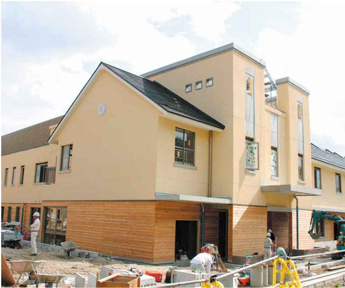
オープンに向けて建設が進むこども支援交流センター(片山町2丁目)
