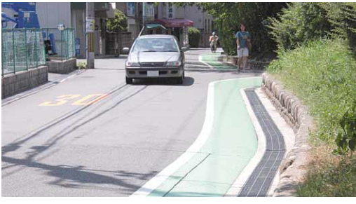
グリーンウォークが設置された道路
