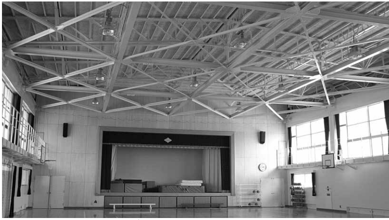
耐震化工事が終了した吹田第二小学校体育館
