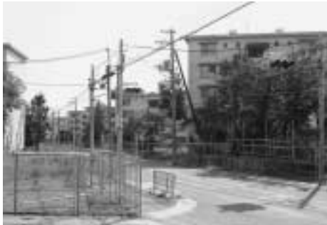
空き家となっているJR職員宿舎棟
