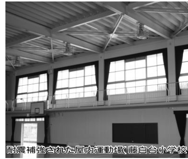
耐震補強された屋内運動場(藤白台小学校)
