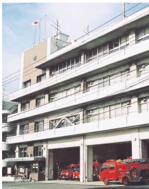
現在、消防本部を有する南消防署
