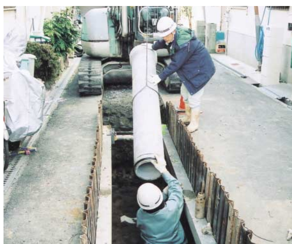
市内で行われている下水道工事
