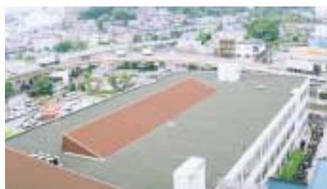
屋上緑化工事が行われる市庁舎
