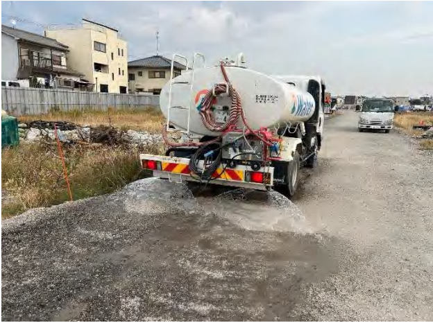
⑦ 散水作業状況
