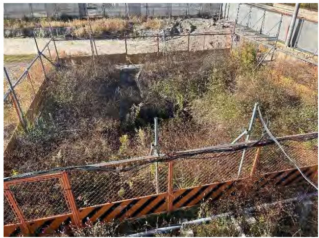
⑧ 沈砂池設置状況
