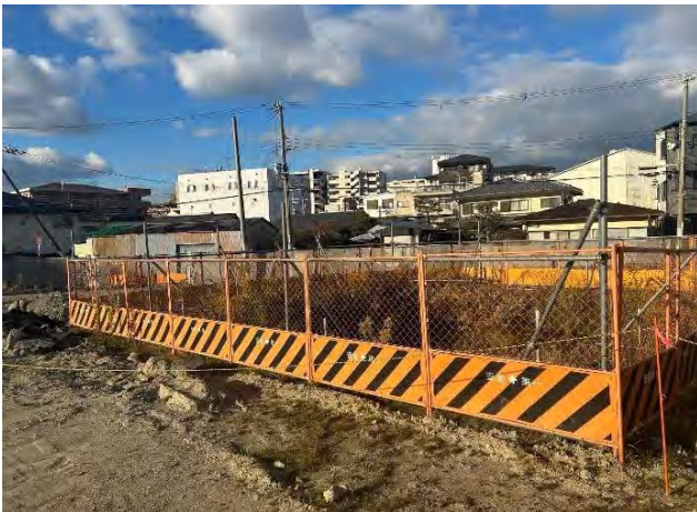
⑨ 沈砂池設置状況
