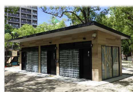
トイレの改修
