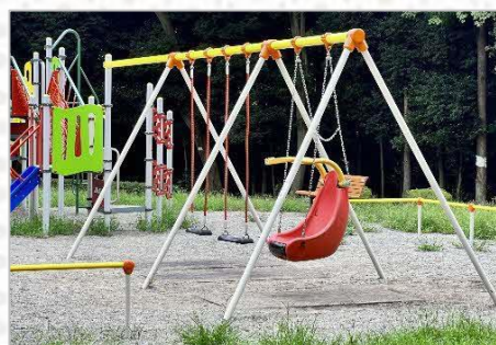
遊具の補修・更新
