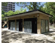
トイレの改修
