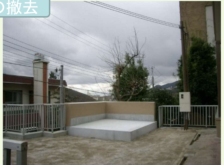
高架水槽の撤去
