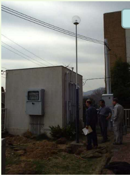
受水槽の撤去
