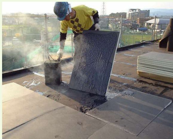
断熱材の施工
