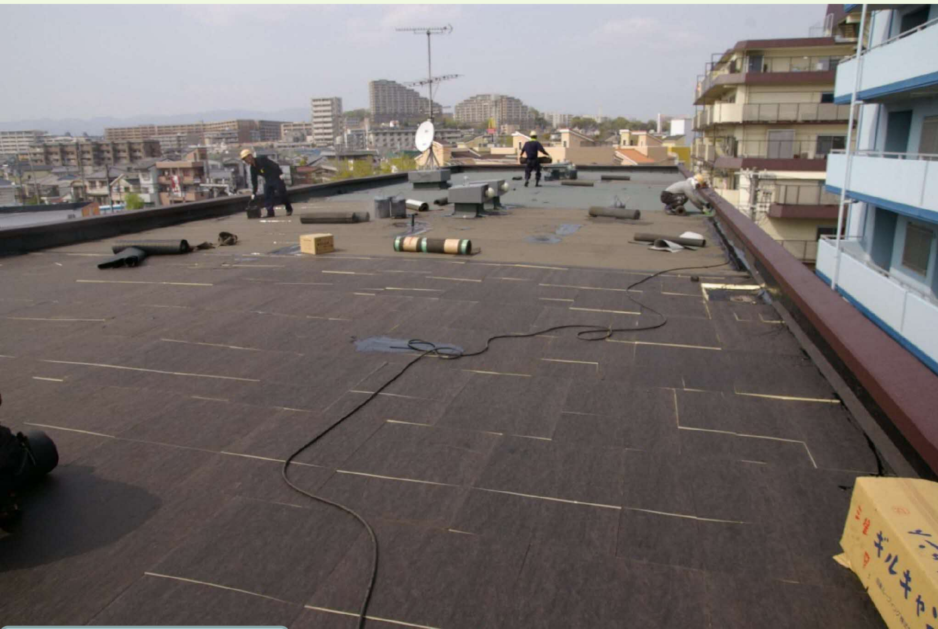
屋上アスファルト防水
