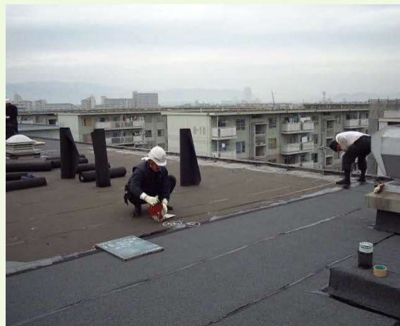
アスファルト防水の施工
