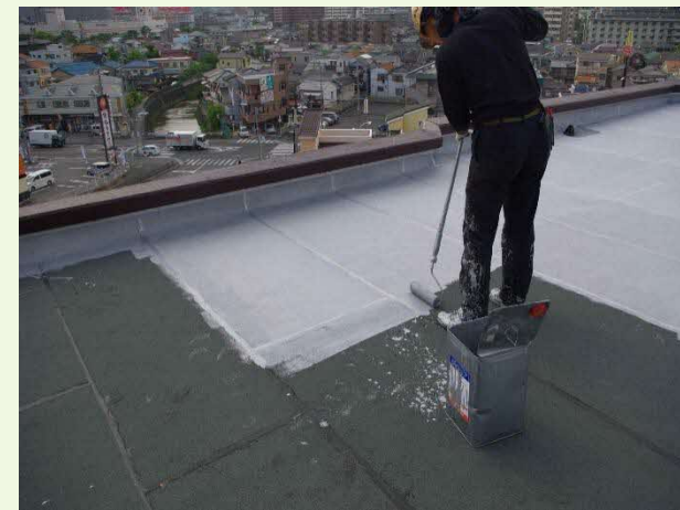
トップコートの施工
