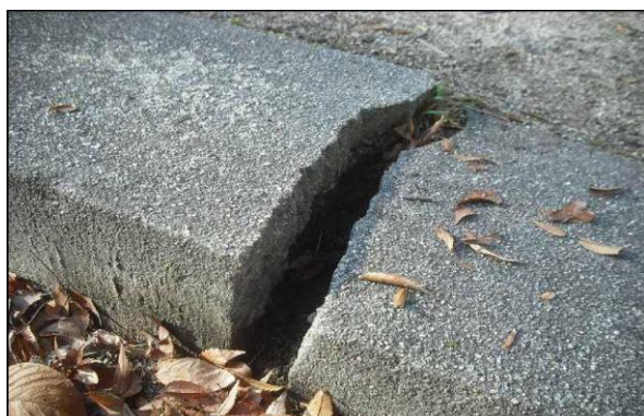
事例 17（しいのき公園：砂場）
