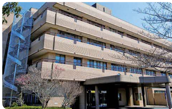
吹田市介護老人保健施設(片山町)
