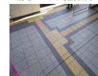
誘導ブロック視認性向上
