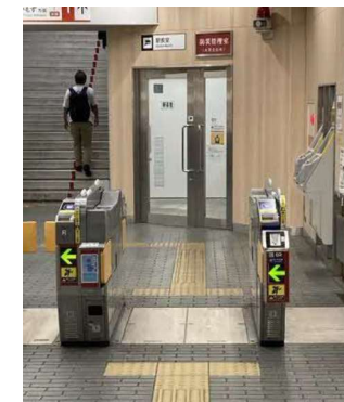
④ 幅広改札機の設置
