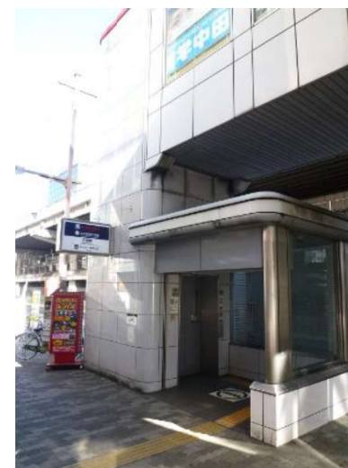
⑤ エレベーター設置
