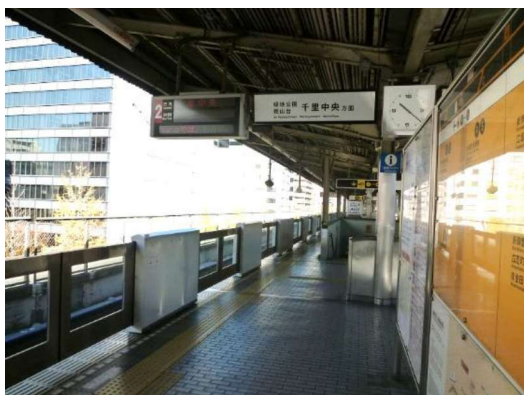
① 可動式ホーム柵設置
