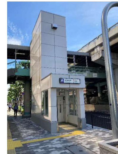
⑥ 複線化エレベーター設置
