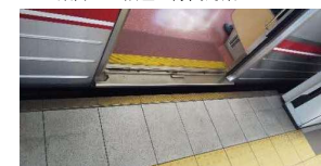
乗降口の段差・隙間対策
