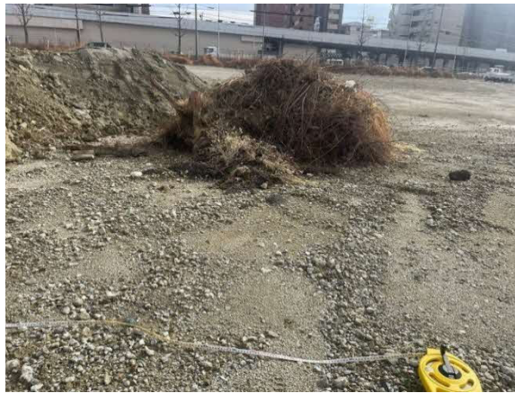
廃棄物対策 (ごみ分別状況)
