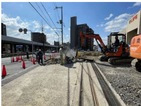
粉じん飛散防止対策 (散水状況)
