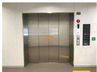
エレベーターの整備
