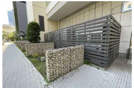
目隠しを設置し、設備機器の存在感を抑制
