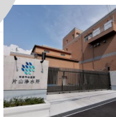
片山浄水所 水処理施設更新 工事
