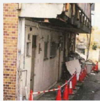
外壁剥落等の危険な状態
