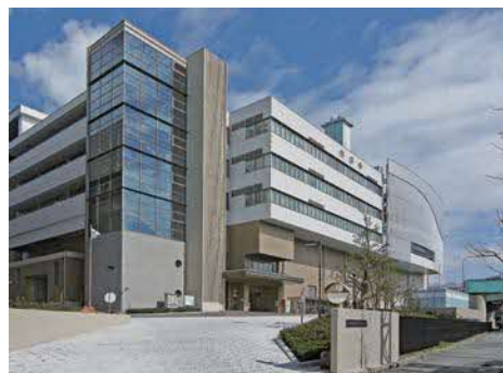
資源循環エネルギーセンター
