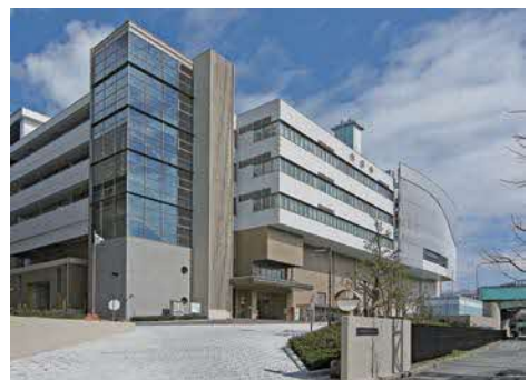
資源循環エネルギーセンター
