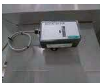
CO 2 センサを導入し、外気導入量を最適化！
