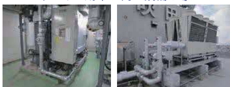
ガス吸収式冷温水発生機！ 空冷ヒートポンプチラー！
