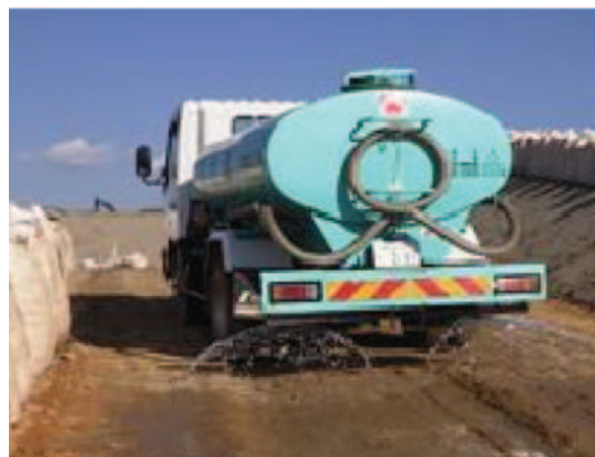
【工事関連車両の走行路への散水】
