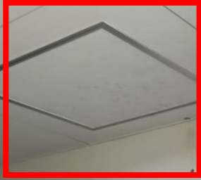
既設管⑤ (階段横倉庫)
