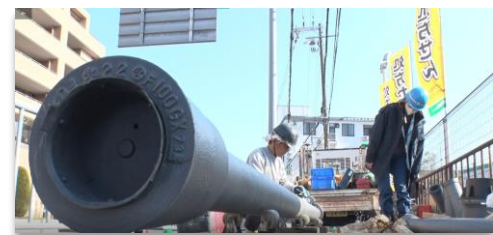
配水支管の整備
