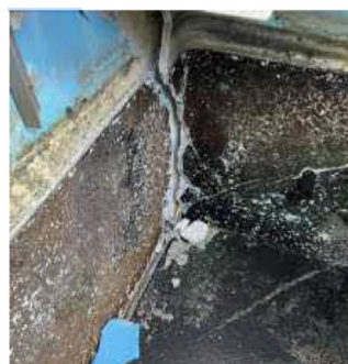
▶ 浄水場沈澱池の 躯体ひび割れ
