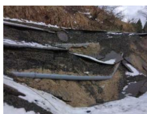
▲ 送水管の被災
