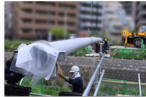
水管橋 (基幹管路) の布設
