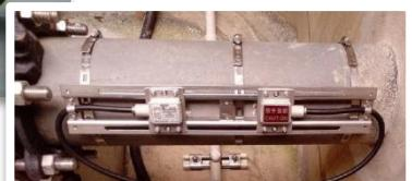
地下水の取水量を計測する水量計
