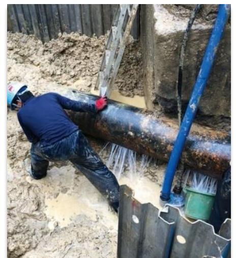
写真7-7 漏水状況
