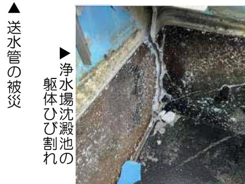
写真4-1 能登半島地震における水道施設被害
