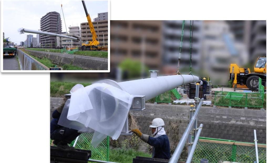
写真7-5 水管橋（基幹管路）の布設
