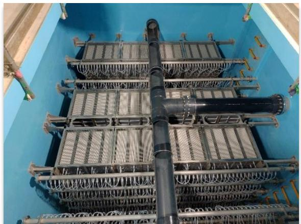
写真7-3 片山浄水所の膜浸漬槽
