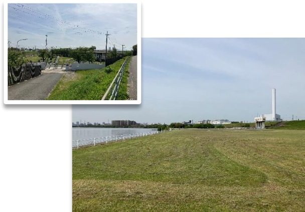
写真6-4 取水場付近 （摂津市西一津屋 淀川右岸）
