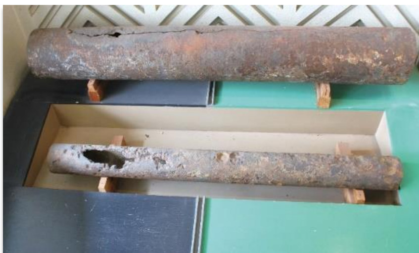
写真7-6 老朽化した水道管
