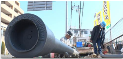
写真6-7 配水支管の整備（現場立会）
