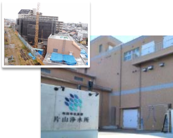
写真7-1 片山浄水所の新処理棟
