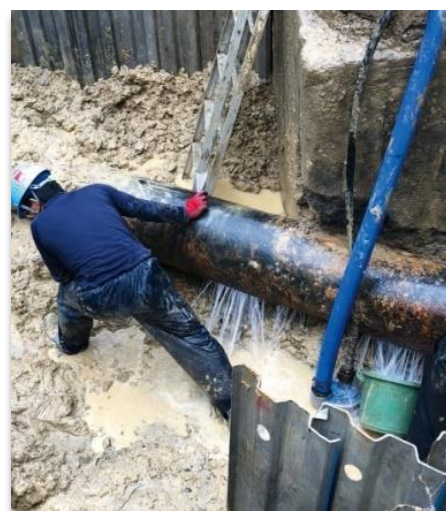
写真7-7 漏水状況
