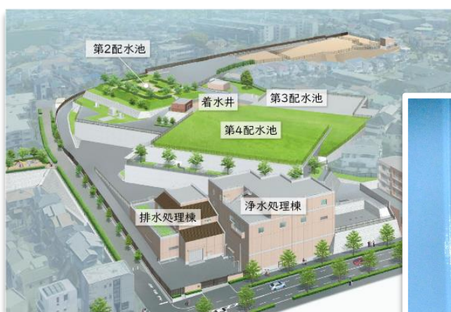
図7-4 片山浄水所内の施設配置
