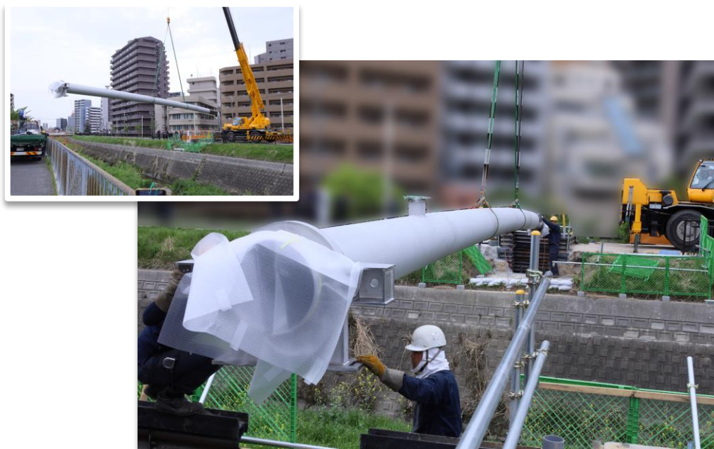
写真7-5 水管橋（基幹管路）の布設
