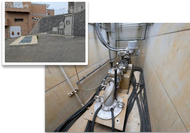
写真6-3 地下水をくみ上げる井戸 （片山浄水所内）
