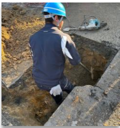
写真6-8 水道管の維持管理（漏水修繕）
