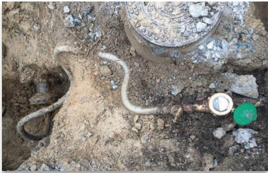
写真6-2 鉛製給水管
