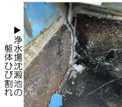
写真4-1 能登半島地震における水道施設被害
