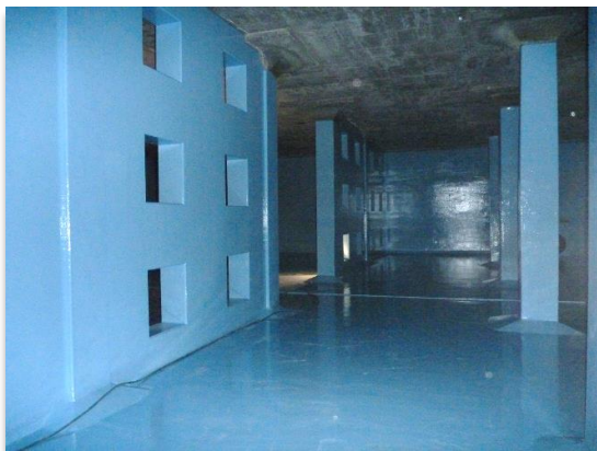
写真6-5 配水池の耐震化（耐震壁）
