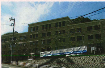
築約90年の建物
