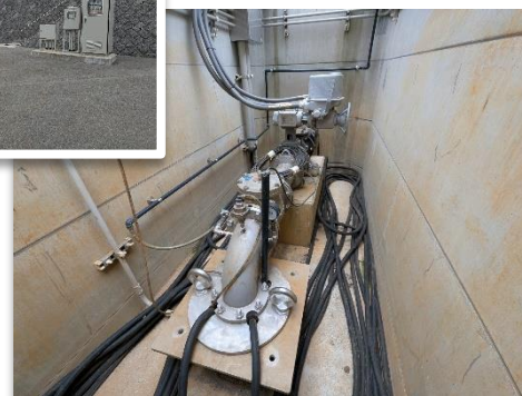
地下水をくみ上げる井戸（片山浄水所内）
