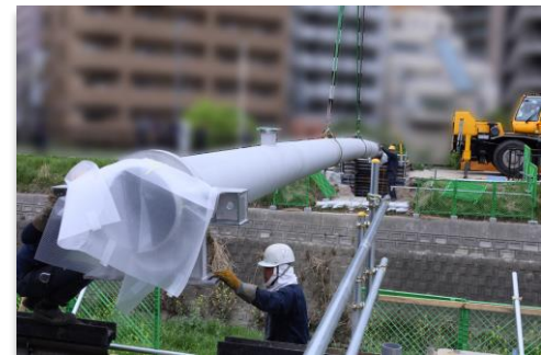
水管橋（基幹管路）の布設
