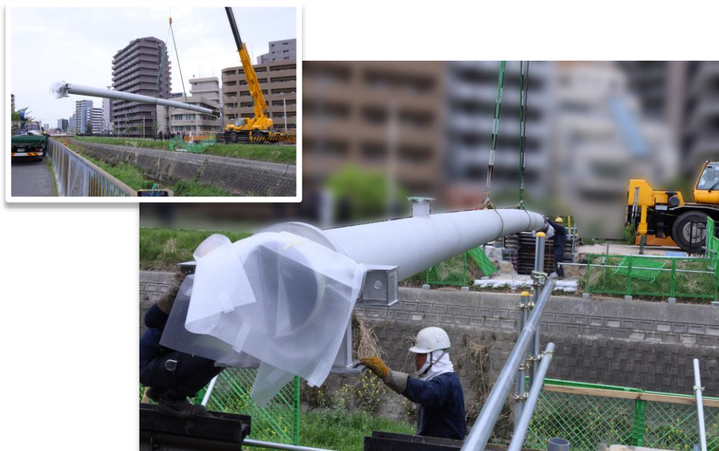
写真7-5 水管橋（基幹管路）の布設
