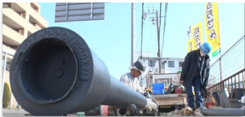
写真6-7 配水支管の整備（現場立会）
