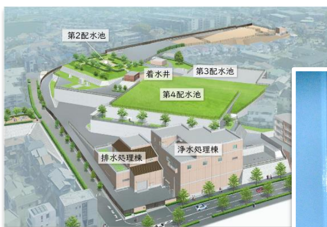
図7-4 片山浄水所内の施設配置
