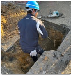
写真6-8 水道管の維持管理（漏水修繕）
