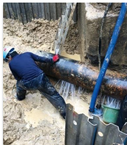
写真7-7 漏水状況
