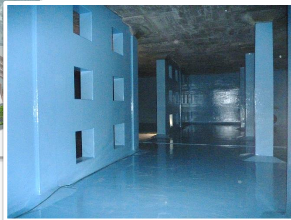
写真7-4 耐震化済みの配水池 (耐震壁)
