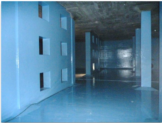
写真6-5 配水池の耐震化（耐震壁）
