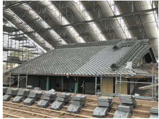
▲主屋 大屋根棧瓦葺き完了
