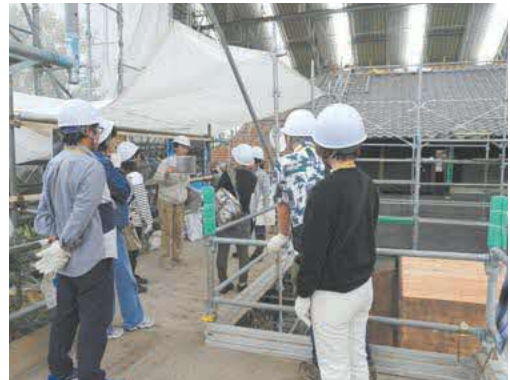
▲修理工事現場見学会の様子
