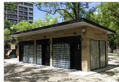
トイレの改修
